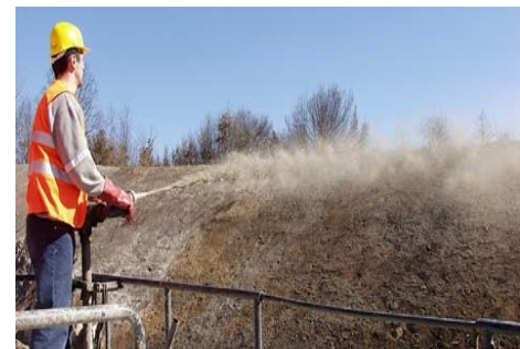
Kerja-kerja menyebarkan biji benih rumput secara 'hydroseeding'
